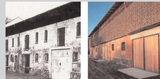
Il ripensamento degli elementi di involucro anche in chiave di sostenibilità ambientale deve tener conto delle caratteristiche originarie delle facciate, in relazione all'alternanza tra pieni e vuoti.
