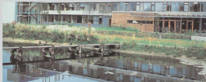
Bacino di raccolta delle acque meteoriche con fasce verdi di bordo filtranti. L'articolazione morfologica del bacino (profilo sinuoso, regolare, ecc.) va valutata anche in relazione alle ricadute di immagine in relazione al sistema degli spazi verdi.
