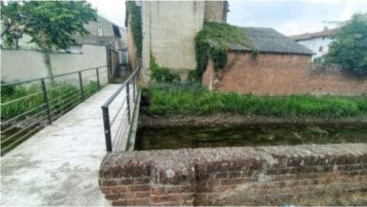
Fino ai primi anni del '900, per collegare via Molino della Costa con via Navazzotti, esisteva un ponte di mattoni, che ora non esiste più, sul cavo Magrelli proprio a sud dell'invaso del Molino Costa. Di questo antico ponte esistono ancora le tracce.
