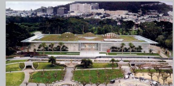
Uso di coperture verdi per diminuire il surriscaldamento delle superfici piane di copertura, e sfruttamento dell'effetto "sfasamento" del terreno per ridurre il trasferimento di calore verso l'interno.
