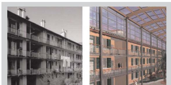
Copertura di spazio aperto a corte delimitato da cortine edilizie per ottenere uno spazio-sera bioclimatico: le attenzioni progettuali devono essere declinate a partire da scelte coerenti con le caratteristiche dell'edificio (materiali, partitura strutturale originaria) e dagli spazi aperti (utilizzando anche gli elementi verdi, in relazione al loro ruolo per la regolazione microclimatica indoor).
